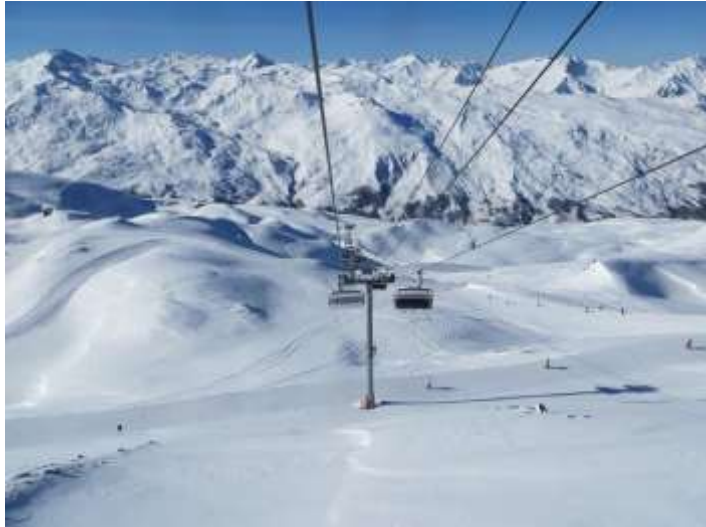
Lift at Trois Vallées
